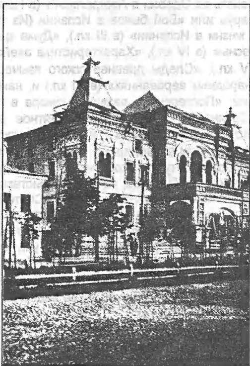
Строительство Романовского музея в Костроме.
